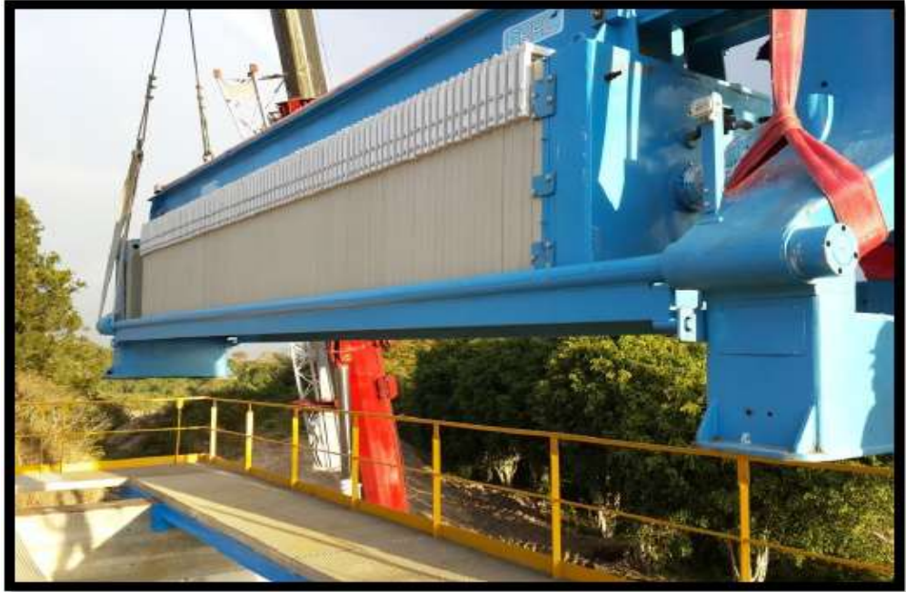
Figura 6: Izaje del filtro prensa FUENTE: Tesis Andrey Rizo Gómez
