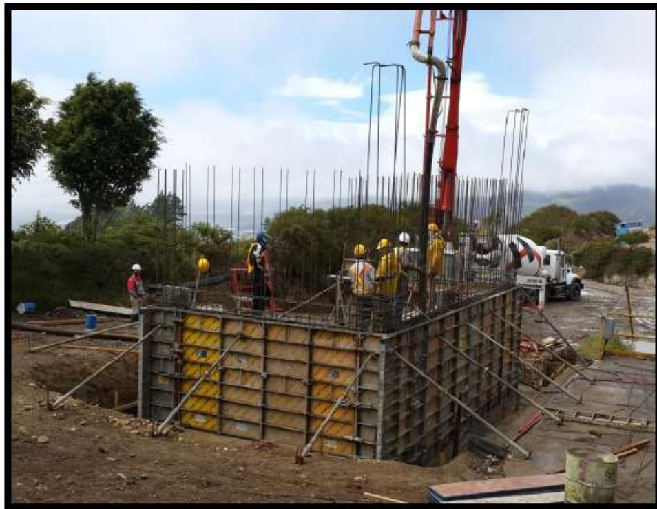
Figura 3: Construcción del muro FUENTE: Tesis Andrey Rizo Gómez
