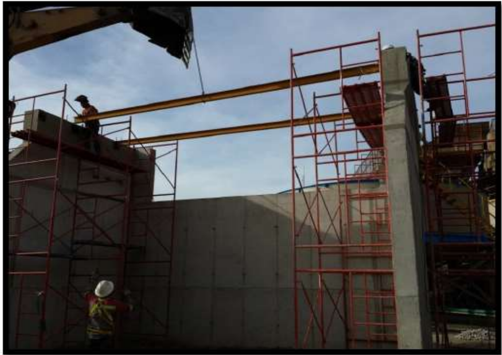
Figura 4: Montaje de vigas en el muro FUENTE: Tesis Andrey Rizo Gómez
