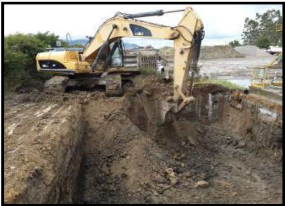
Figura 1: Movimiento de tierra FUENTE: Tesis Andrey Rizo Gómez
