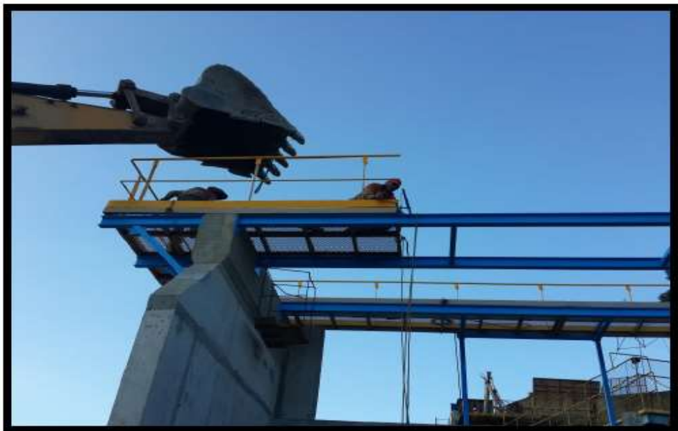
Figura 5: Montaje de pasarelas FUENTE: Tesis Andrey Rizo Gómez
